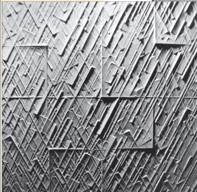
Reliefmuster „Kristalline Struktur“ für Außenwandelemente, Strukturbeton-Entwürfe für das Institut für Stahlbeton Dresden sowie Ausführung des Urmodells zur Matritzenherstellung (Gips M 1:1), Dresden 1988
